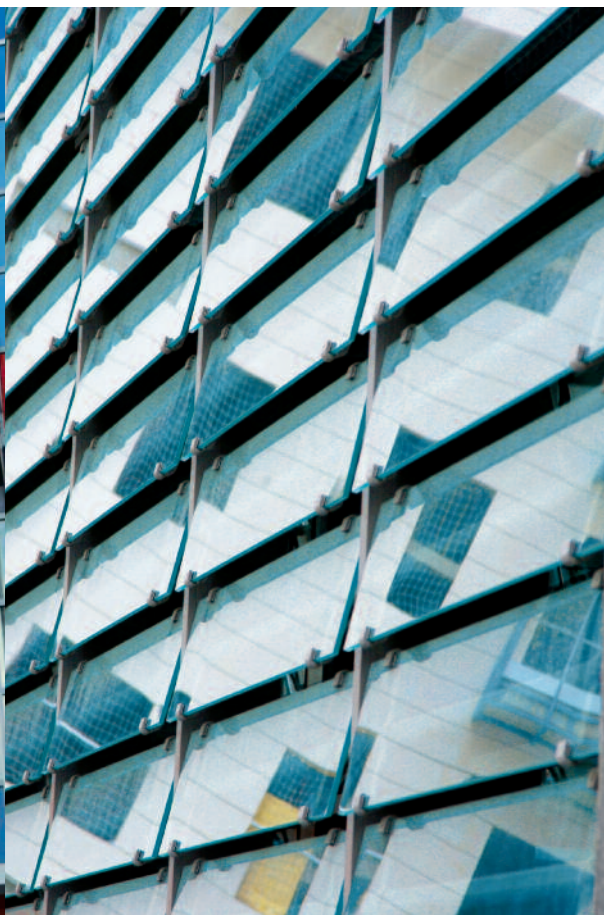
D11 - Frangisole verticale. Angoli prestabiliti e variabili. Collegabile frontalmente e lateralmente alla muratura ed alle sottostrutture in acciaio.
