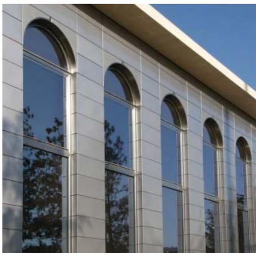
**L'acciaio inox è caratterizzato da una conduttività termica 10 volte inferiore all'alluminio e dall'altissima resistenza alla corrosione.**
